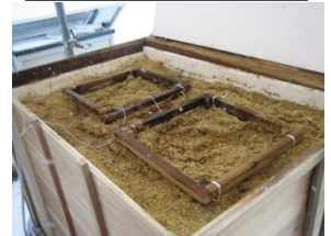
地下約3mでの採熱管(2段目)敷設状況
