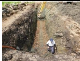
地下約3mでの採熱管(2段目)敷設状況
